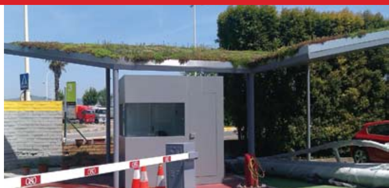
Casetas de vigilancia para parking
